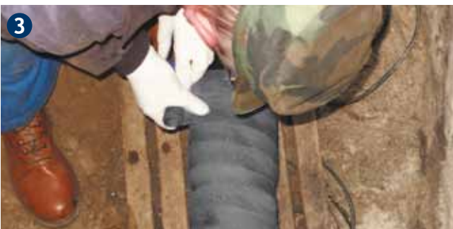
Wickeln des PSI Pipecast-Bandes mit mind. 1 x 75% (4 Lagen) Überlappung nach Tränkung mit Wasser
