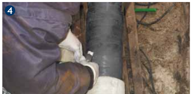
Die Enden des PSI Pipecast-Bandes mit Klebeband umwickeln, um die Enden fest an das Rohr zu drücken
