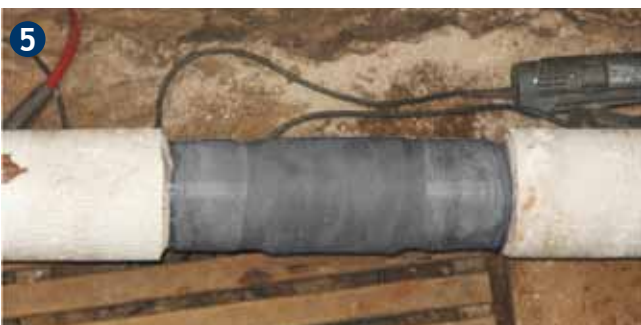
Aushärten des PSI Pipecast bei 23 °C ca. 20-30 Minuten, einziehbar nach ca. 1 Stunde
