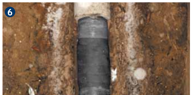
PSI Pipecast nach der Pressung
