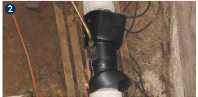
Montage des Schrumpfschlauches
