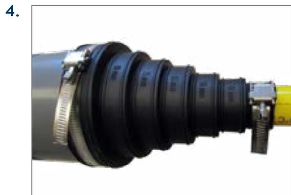
Spannbänder anlegen und festziehen. Das überstehende Band kann abgeschnitten werden.
